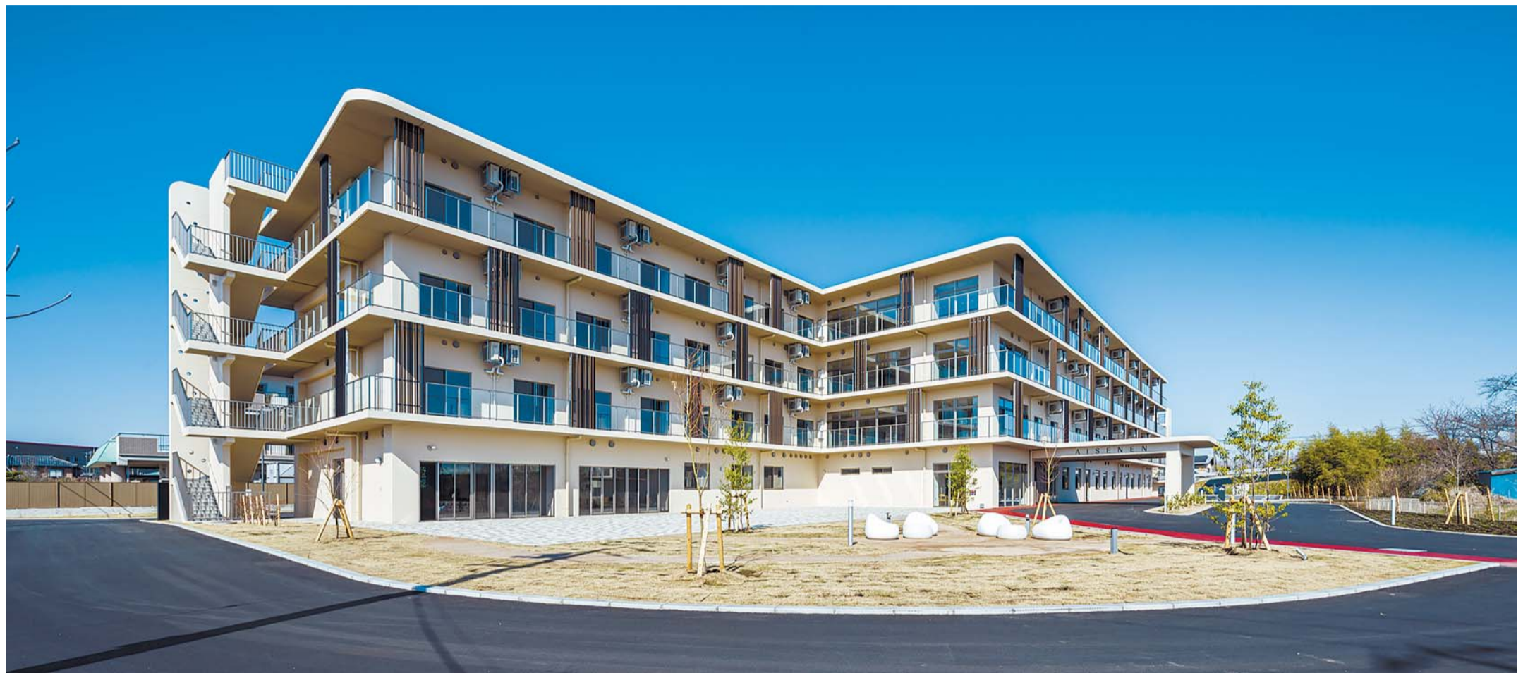
設計・監理 新環境設計 施工 古郡建設
